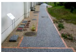
写真1 ポーラスコンクリートの実施工実験
