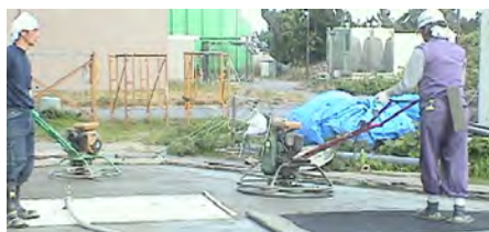
写真3 真空脱水工法の現場実験
